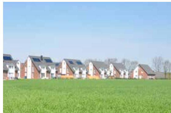
14. Bebauung Gerhard-Bachmann-Ring, Neu Wulmstorf
